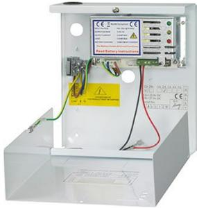
Box compatto per alloggiamento batteria di emergenza ARRONE:
